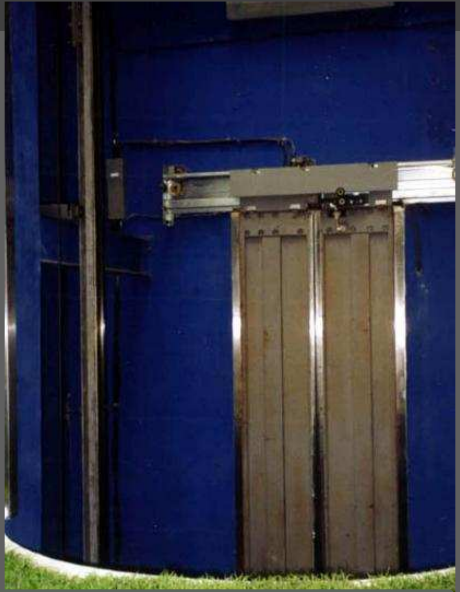
■ 电梯井内的轿厢导轨及电梯门启合装置
