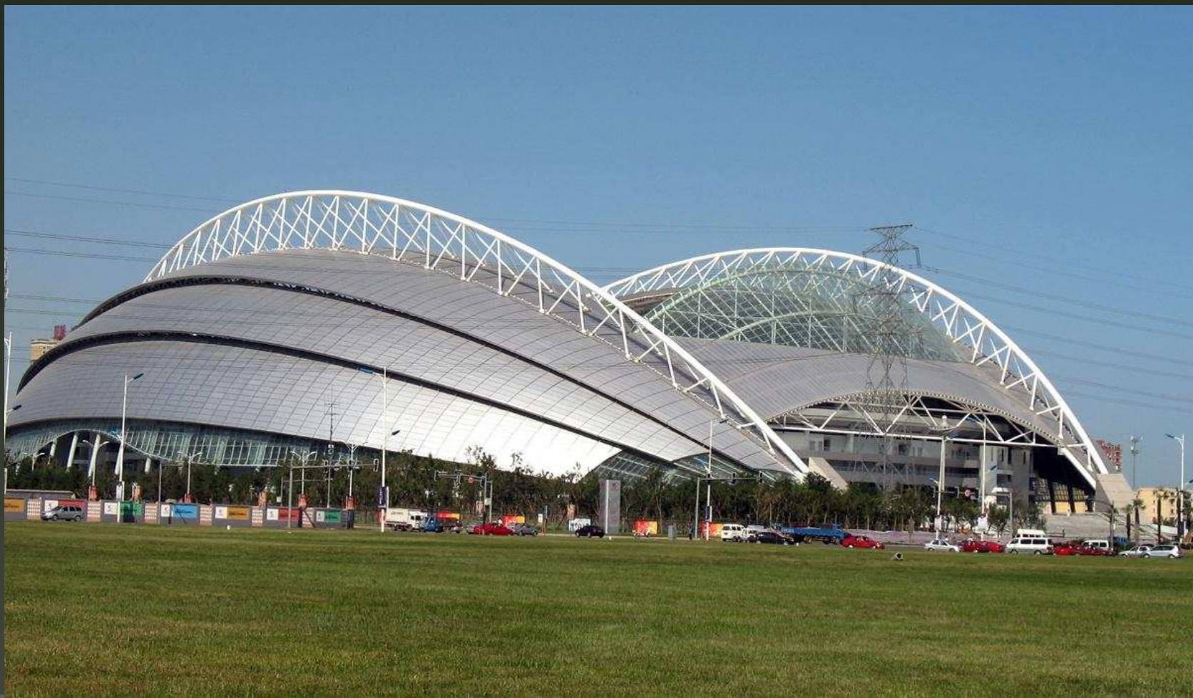
■ 钢网架结构的曲面屋盖
