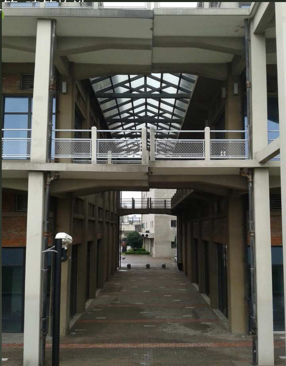
■ 某建筑底层留出穿越通道，上部的连接由两侧分别向中间悬挑
