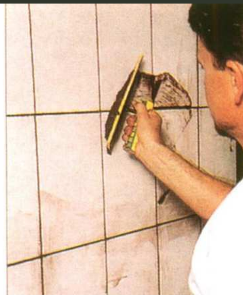
铺贴完成24小时以后，方可踏入及填缝。
