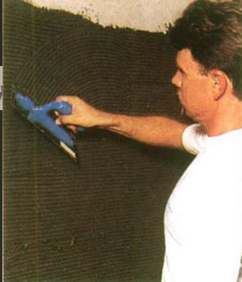
用合适的齿型刮板将胶浆涂抹于工作面，使之均匀分布成条齿状，每次约1.2米左右。
