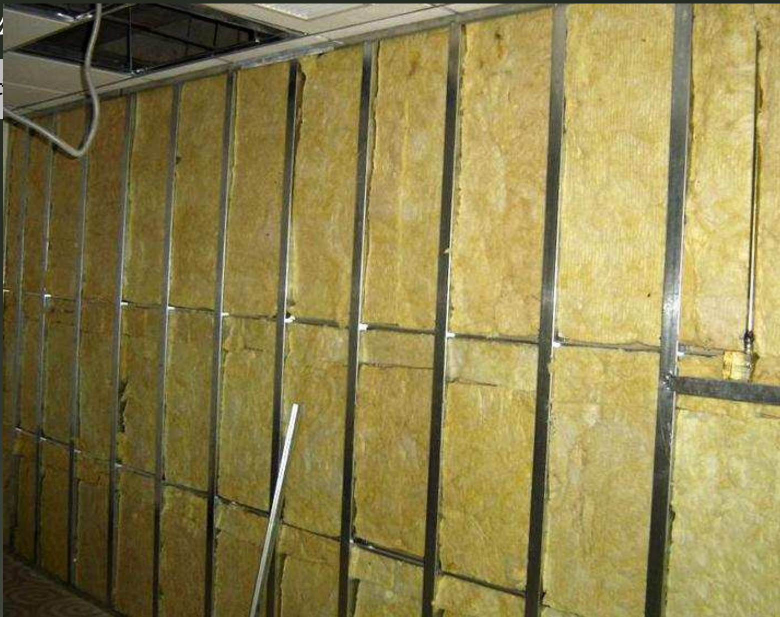
■ 隔墙龙骨间置入岩棉材料以提高防火及隔声性能的实例
