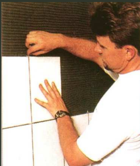
使用合适的砖缝十字调节砖缝间距。
