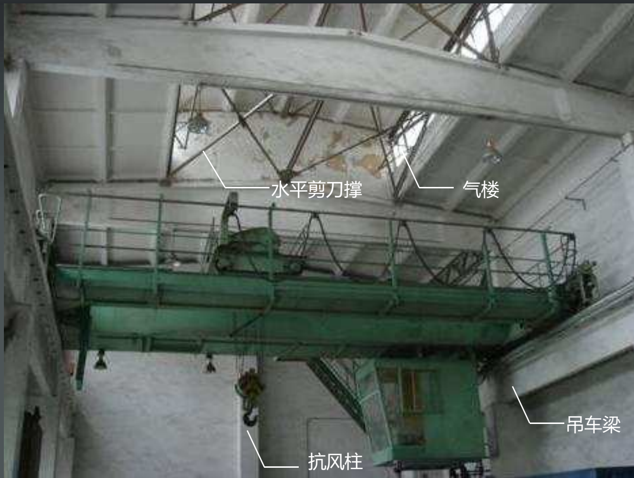
■ 带有起吊设备的某排架结构工业厂房
