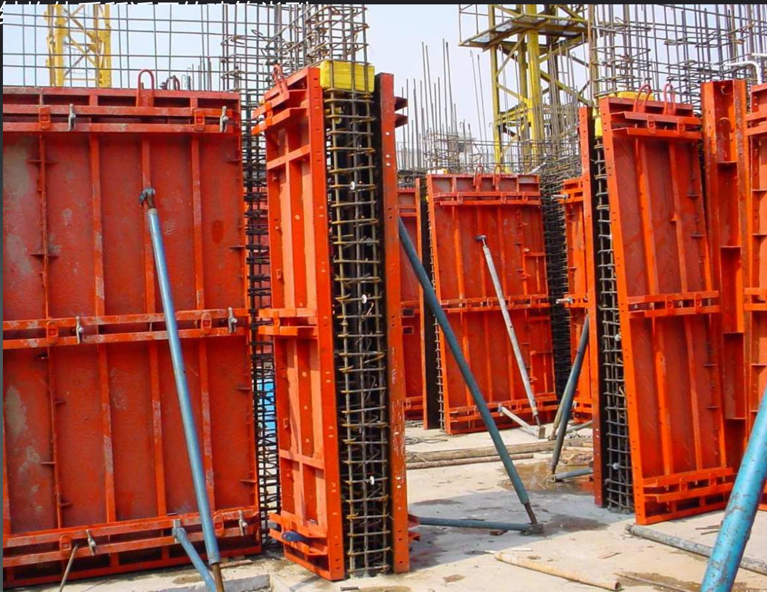
■ 墙承重体系建筑钢筋混凝土墙体施工现场
