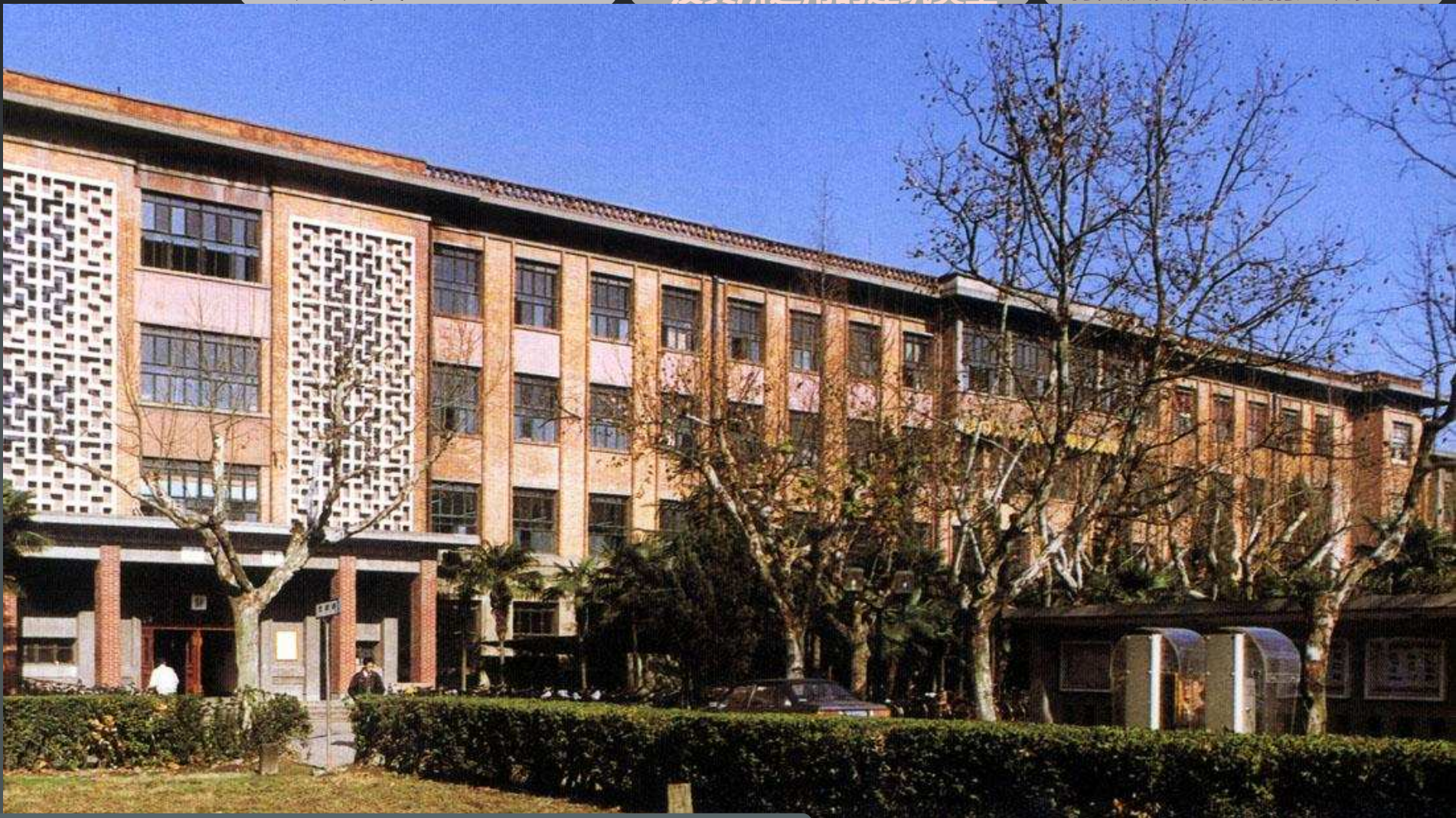
■ 砖墙承重的混合结构多层教学楼
