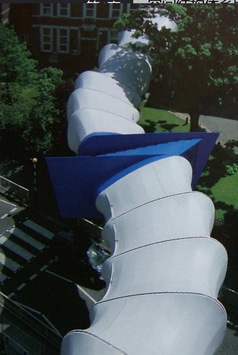
■ 采用张拉膜结构的连廊
