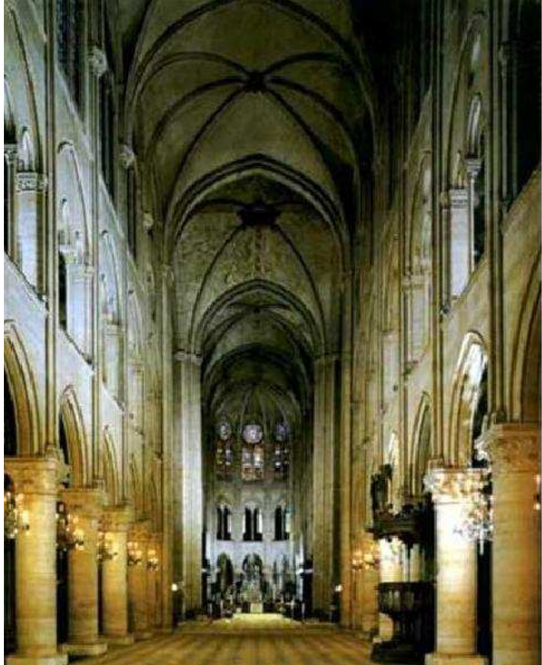
骨架券作拱顶承重构件，其余填充部分减薄，使自重轻。
