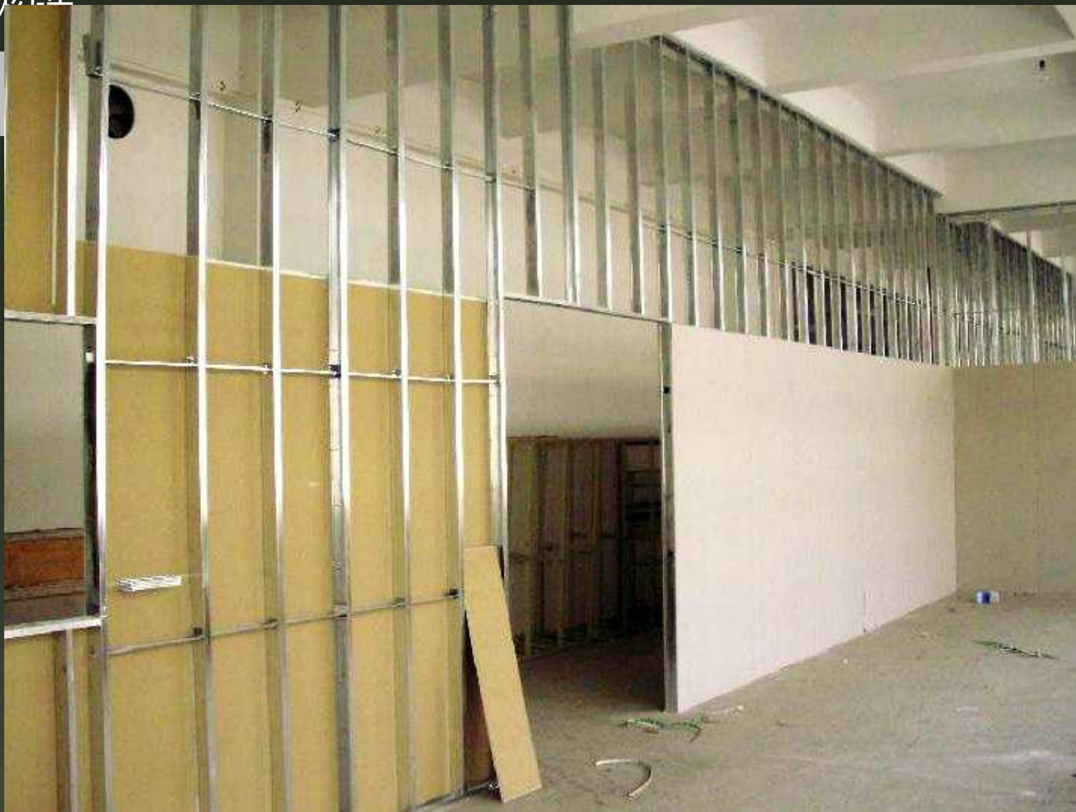
■ 轻钢龙骨纸面石膏板隔墙实例一则
