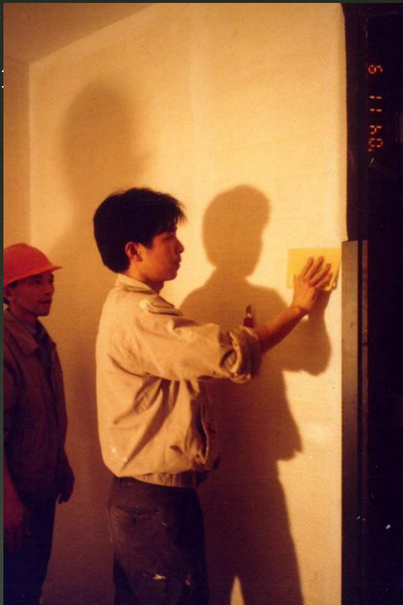
■实际作业过程中推赶气泡和对墙布进行修边的情况
