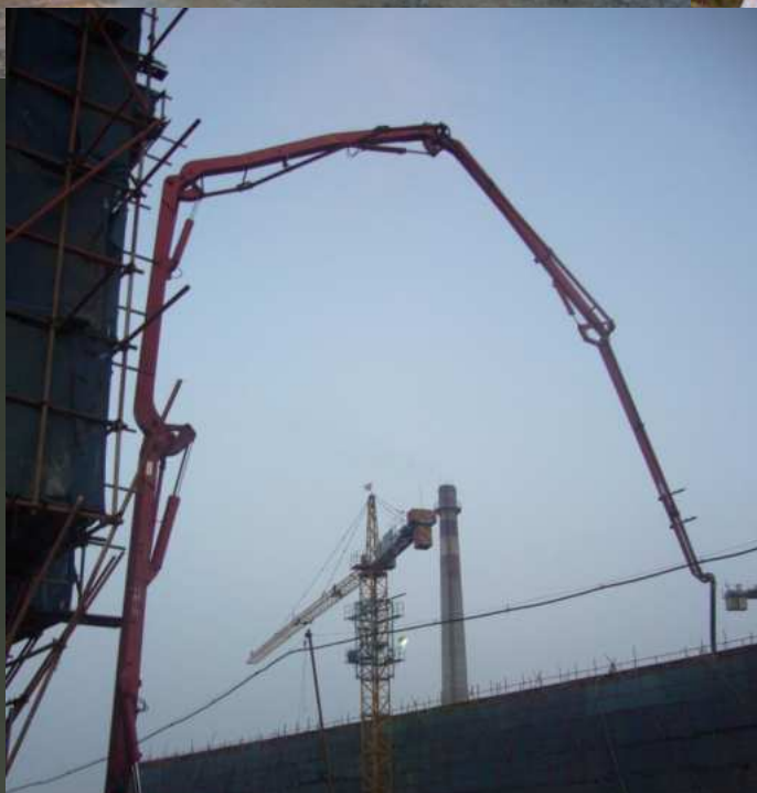
■ 运送商品混凝土到现场整体浇筑
