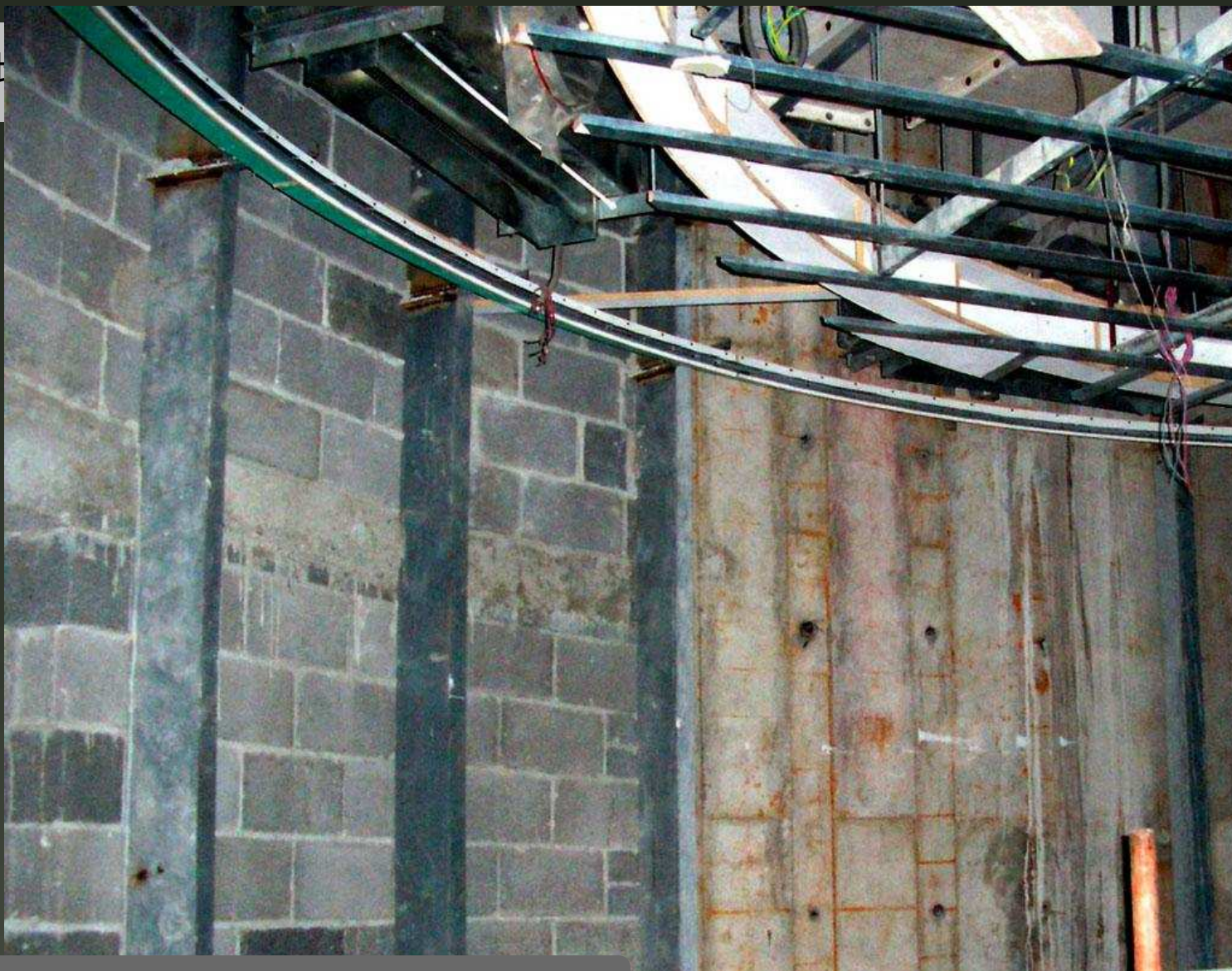
■ 砌块墙和钢筋混凝土墙
