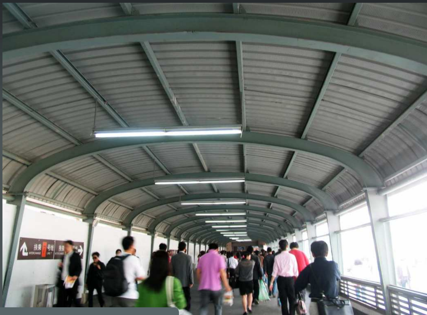
■ 某刚架结构的轨道交通换乘通道
