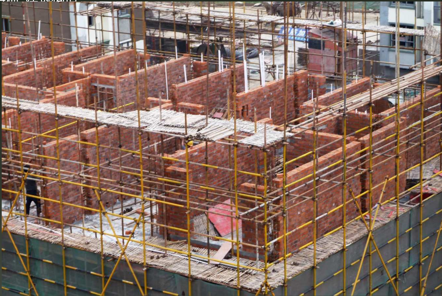
■ 现场在指定部位设置构造柱的情况
