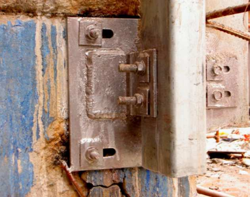
重外墙板及 的基本构造
