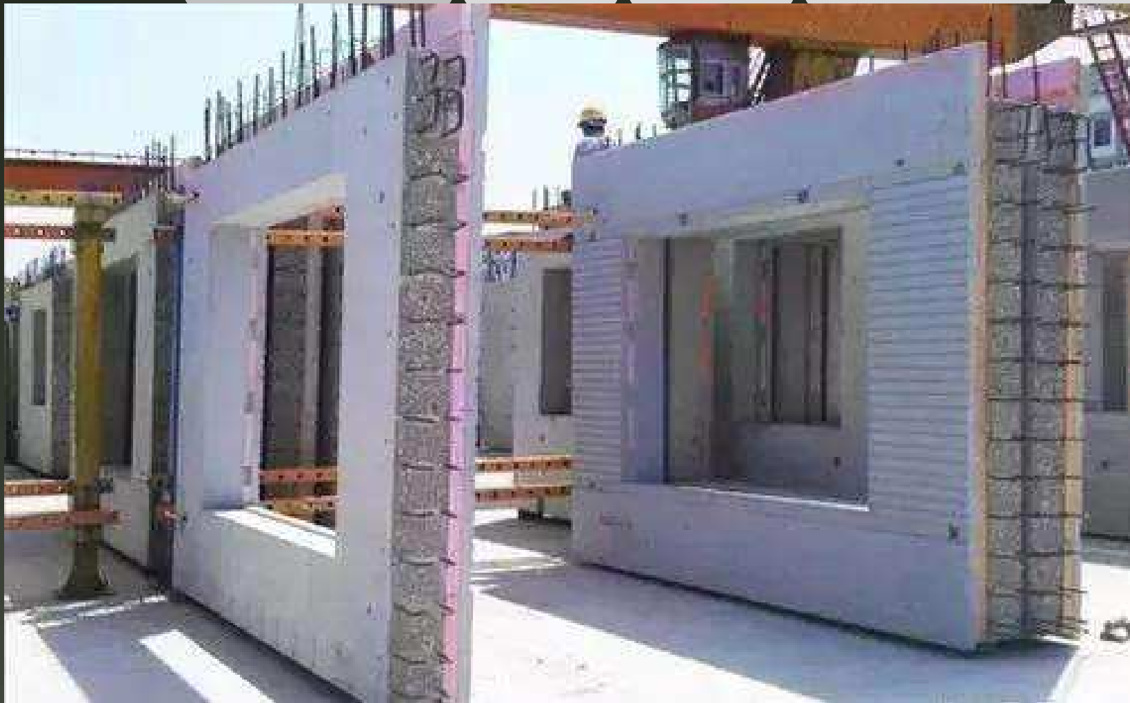
■ 复合保温材料的钢筋混凝土夹芯外墙板
